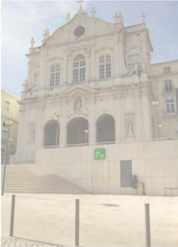
Fig. 1 - Fachada principal da Igreja de Jesus e intervenção do estacionamento subterrâneo, 2008
