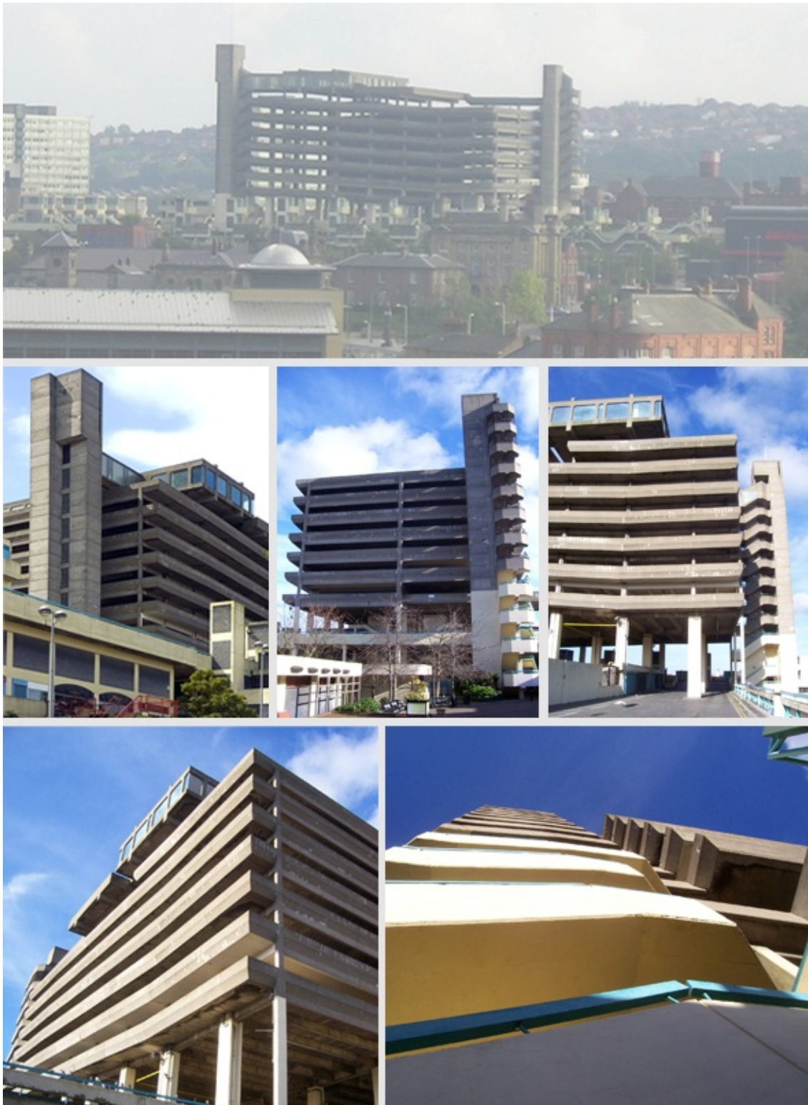
Fig. 1 - Perspectiva geral e Pormenores da construção
