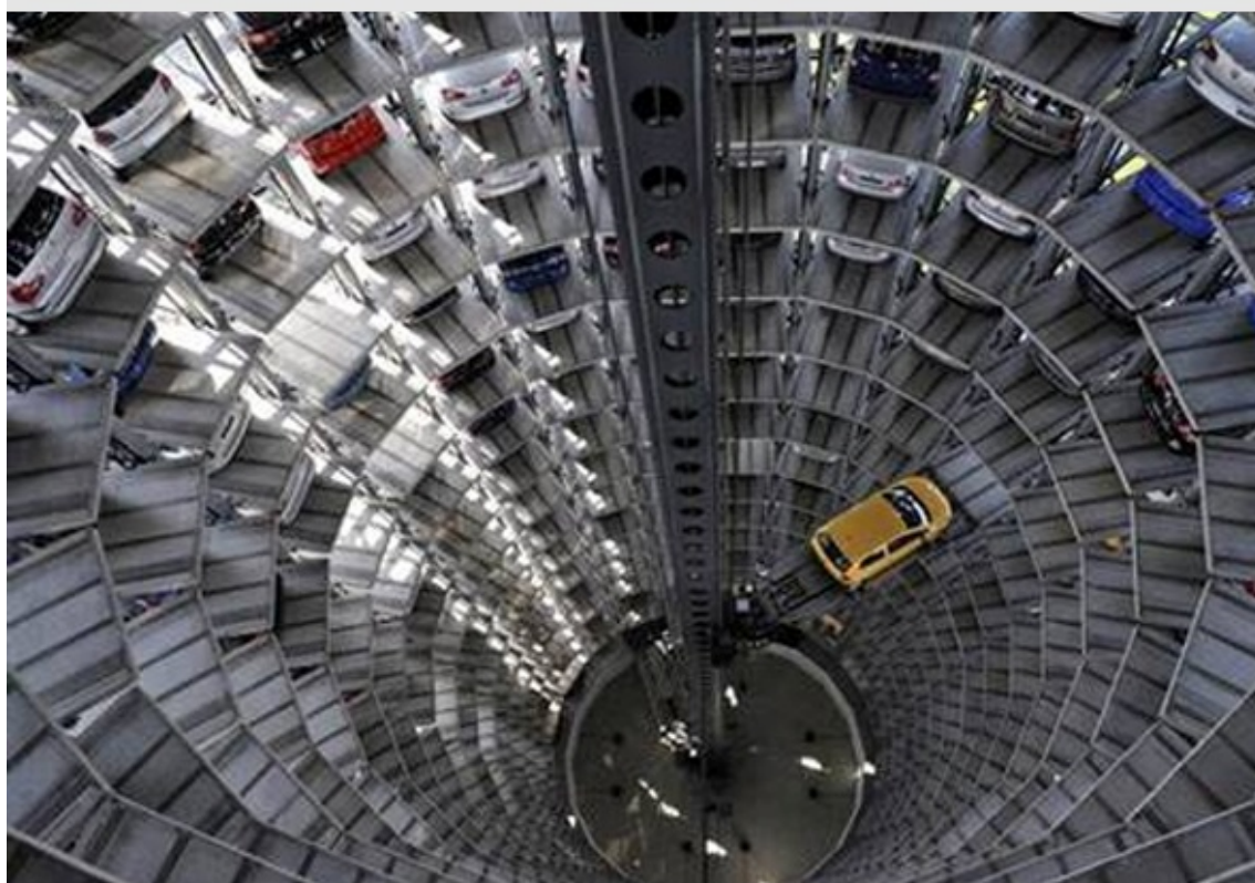
Fig. 1 - Perspectiva geral e Pormenores da construção
