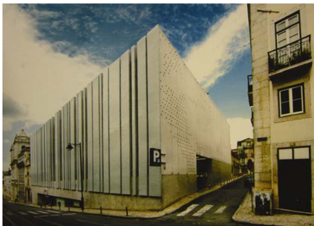
Projecto 6 - Silo de Estacionamento Calçada do Combro , 2003
