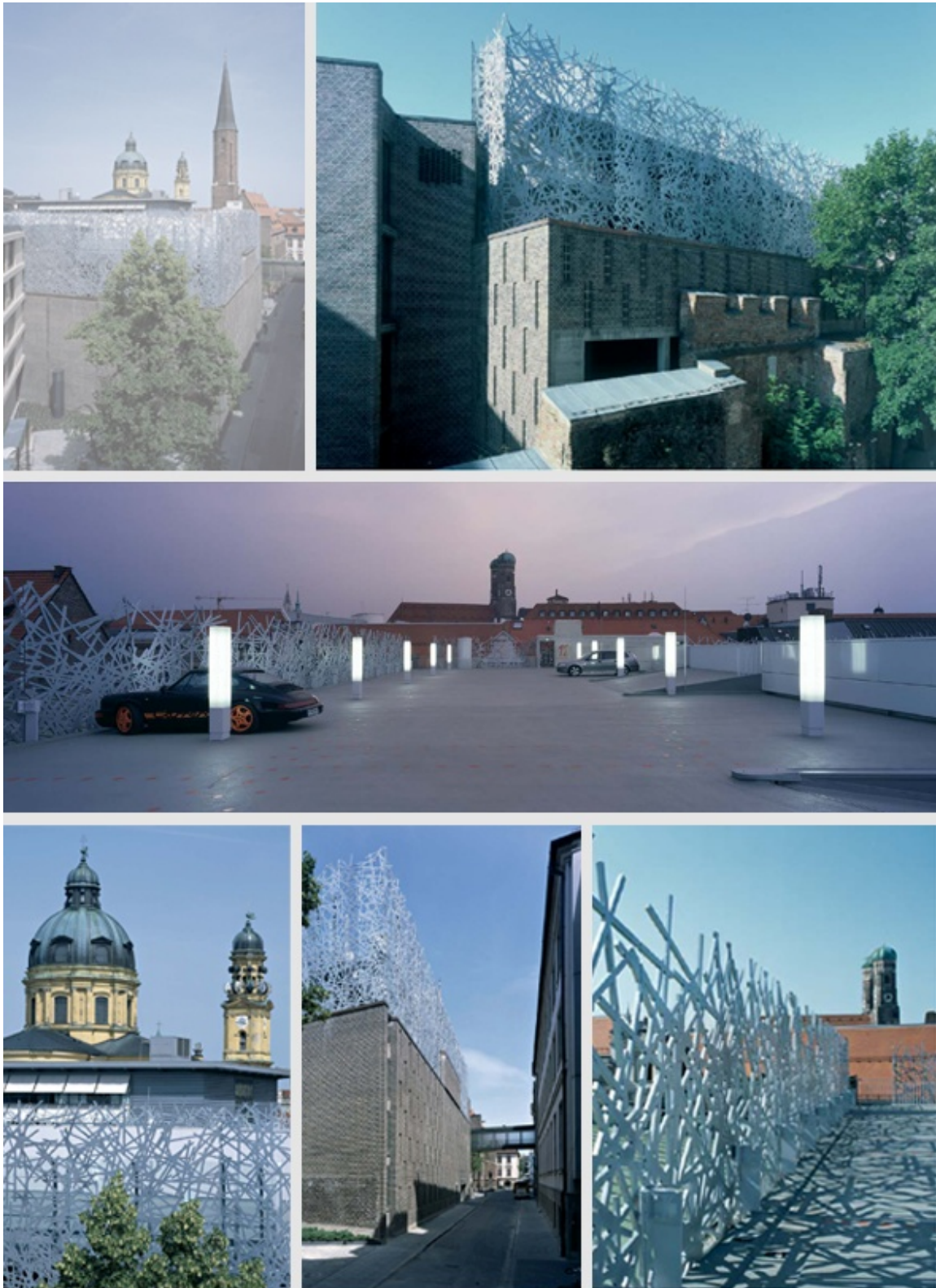
Fig. 1 - Perspectiva geral e Pormenores da construção
