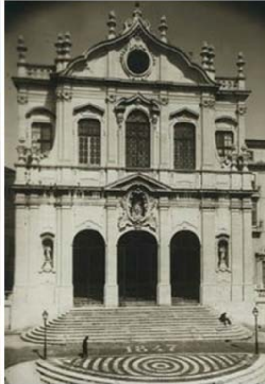
Fig. 2 - Fachada Principal da Igreja de Jesus – Arquivo Municipal
